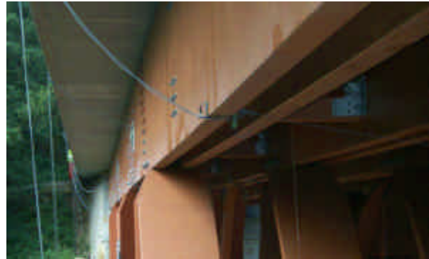
Figure 5.1b – Positionnement d'accéléromètres
