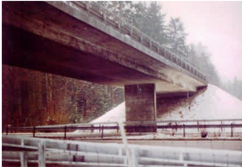
Figure 6.1 – Essais dynamiques sur le pont Z24 (projet européen SIMCES)
