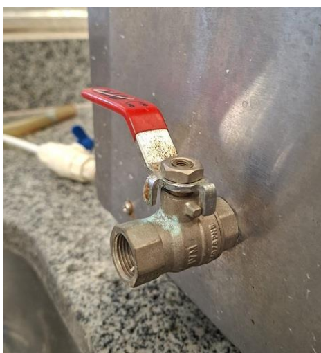
Figura 2 - Válvula de saída de água na posição fechada.
