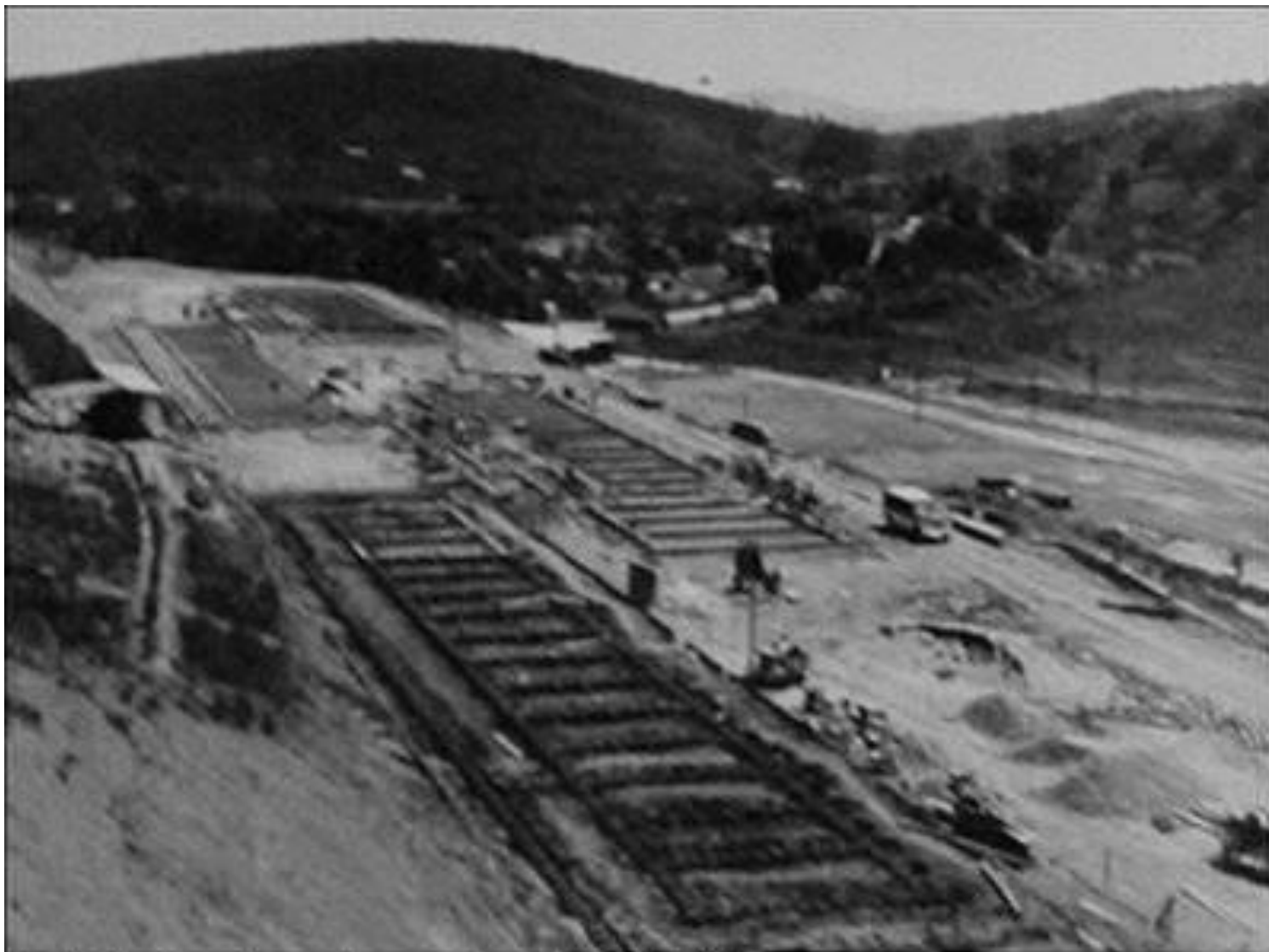
O início das obras de construção da UFJF
