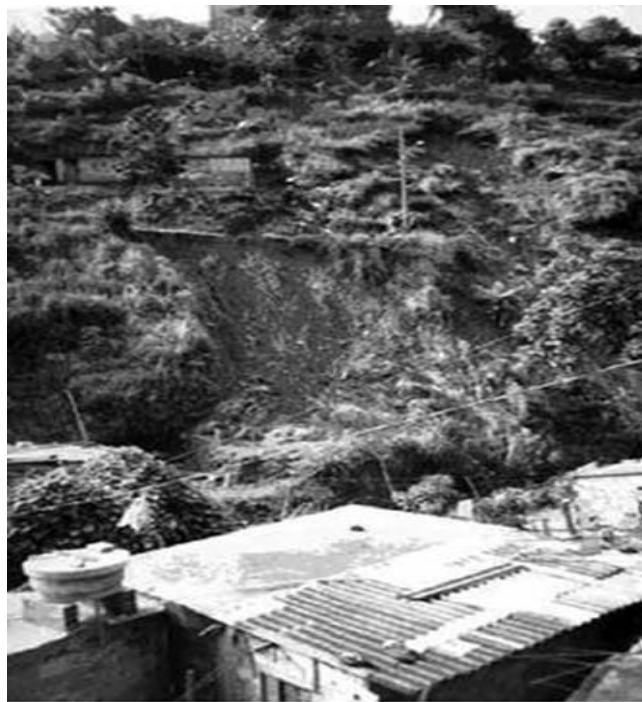
Figura 18 - Deslizamento Planar em talude no bairro Taquaril
