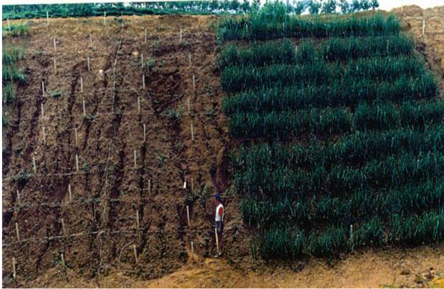
Figura 4 - Uso do Capim Vetiver no combate a erosão do solo
