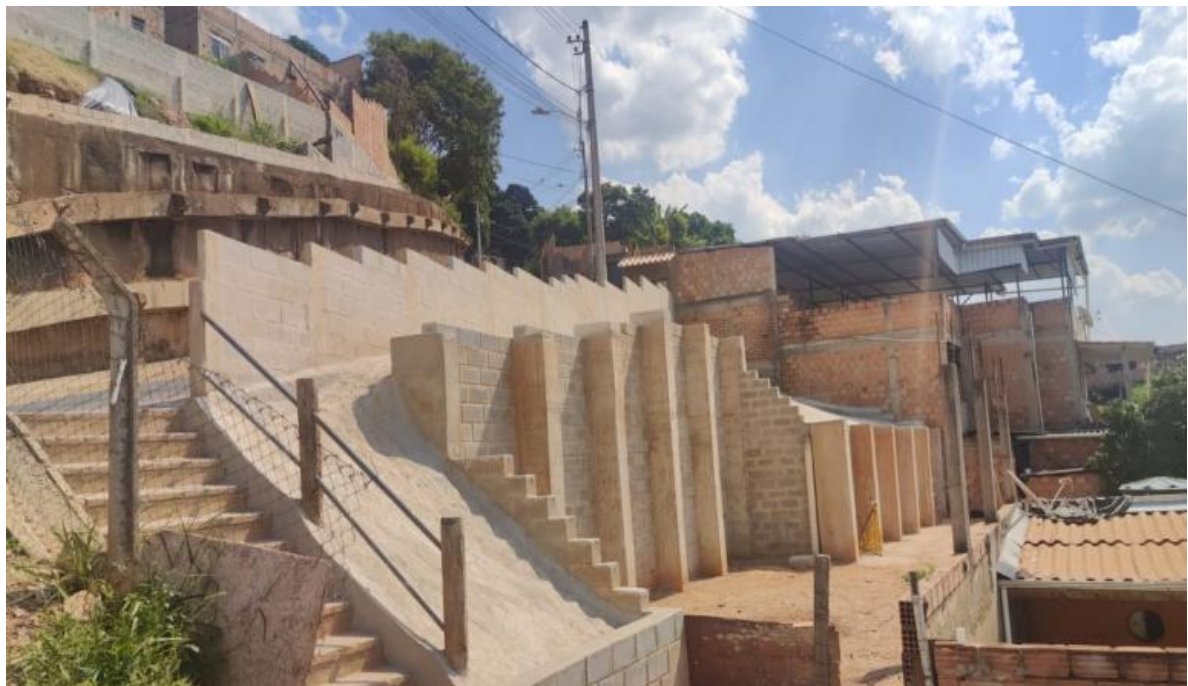
Figura 26 - Estabilização de Encosta com Muro de Contenção no bairro Taquaril
