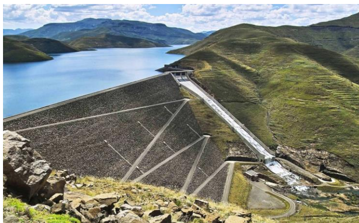
Figura 09: Barragem de enrocamento (Barragem de Mohale, Lesoto)
