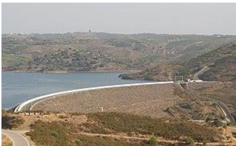
Figura 08: Barragem de terra (Barragem de Beliche, Portugal)
