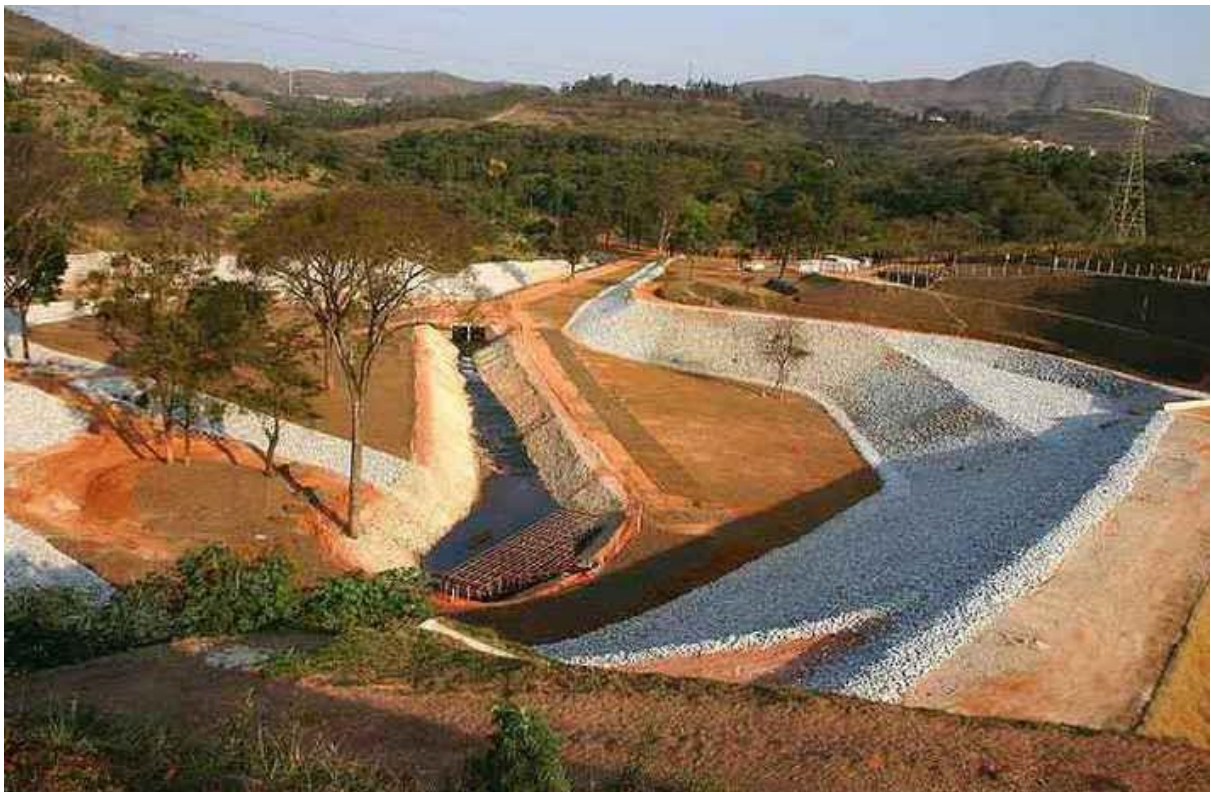
Figura 13 – Reservatório de detenção in-line no córrego Bonsucesso, em Belo Horizonte - MG
