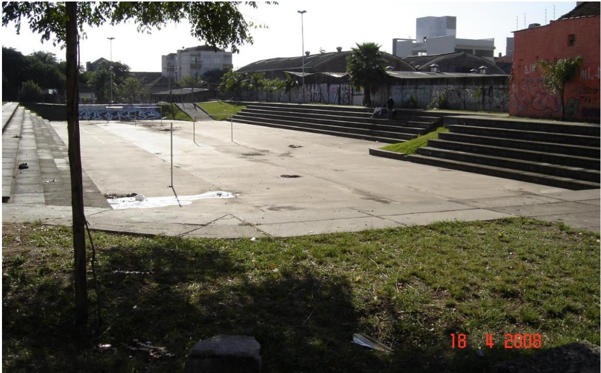
Figura 12 – Reservatório de detenção off-line na Praça Júlio Andreatta - Porto Alegre, RS.
