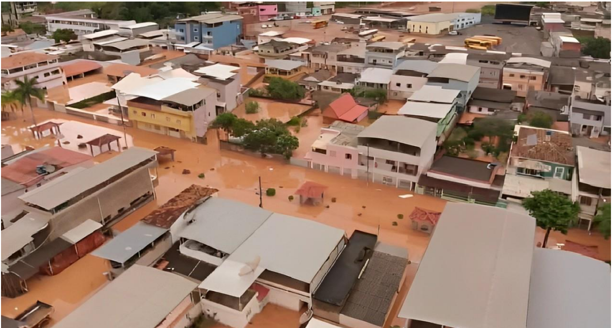
Figura 3 – Centro do município de Espera Feliz-MG acometido pela inundação de janeiro de 2020
