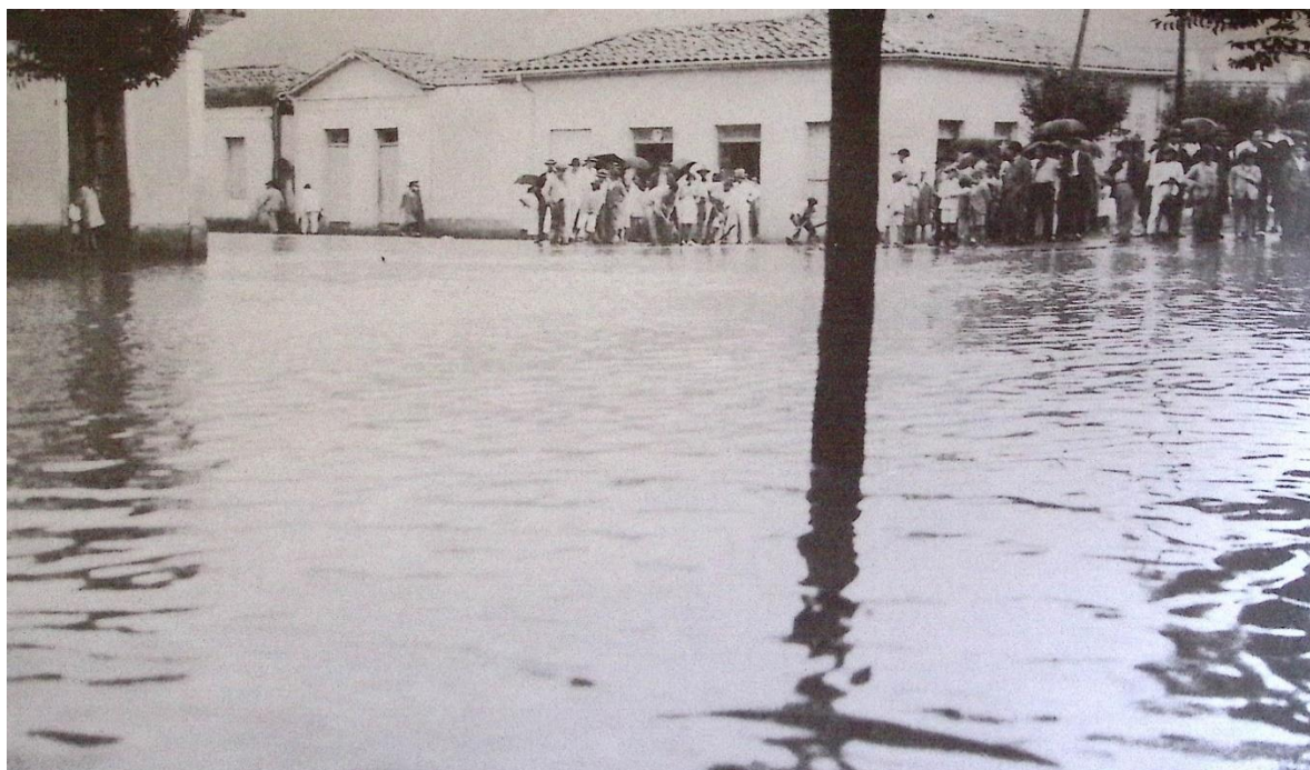
Fotografia 4 – Alagamento na antiga Rua Marquês de Paraná, atual Rua Assis Figueiredo – Ano: 1926
