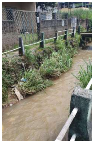
Figura 8 - Córrego Ipiranga - Juiz de Fora/MG - Rua Doutor Ettiene Loures - Bairro: Ipiranga. Canal retilíneo com proteção de margens com muro de gabião.
