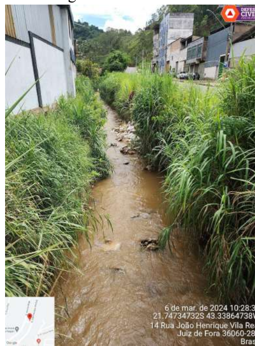
Figura 62 - Ponto 33 - Vista do Ribeirão Yung em seção localizada na interseção entre as Ruas João Henrique Vila Real e Vitorino Braga.
