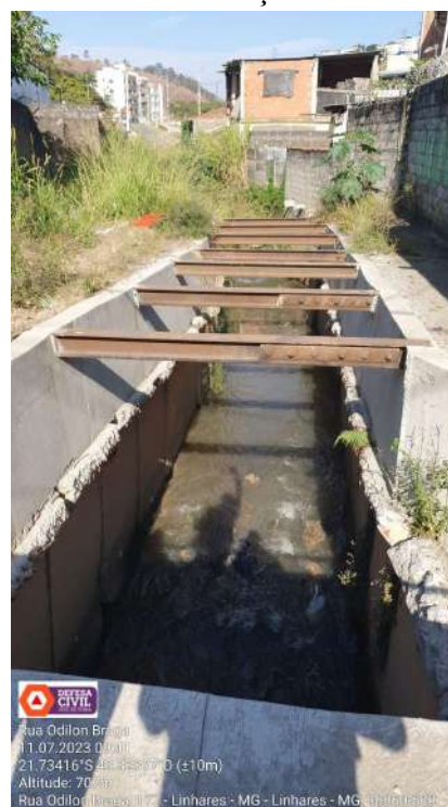
Figura 58 - Ponto 29 - Vista de seção do Ribeirão Yung localizada à Rua Odilon Braga, onde suas margens foram protegidas com estrutura de contenção.
