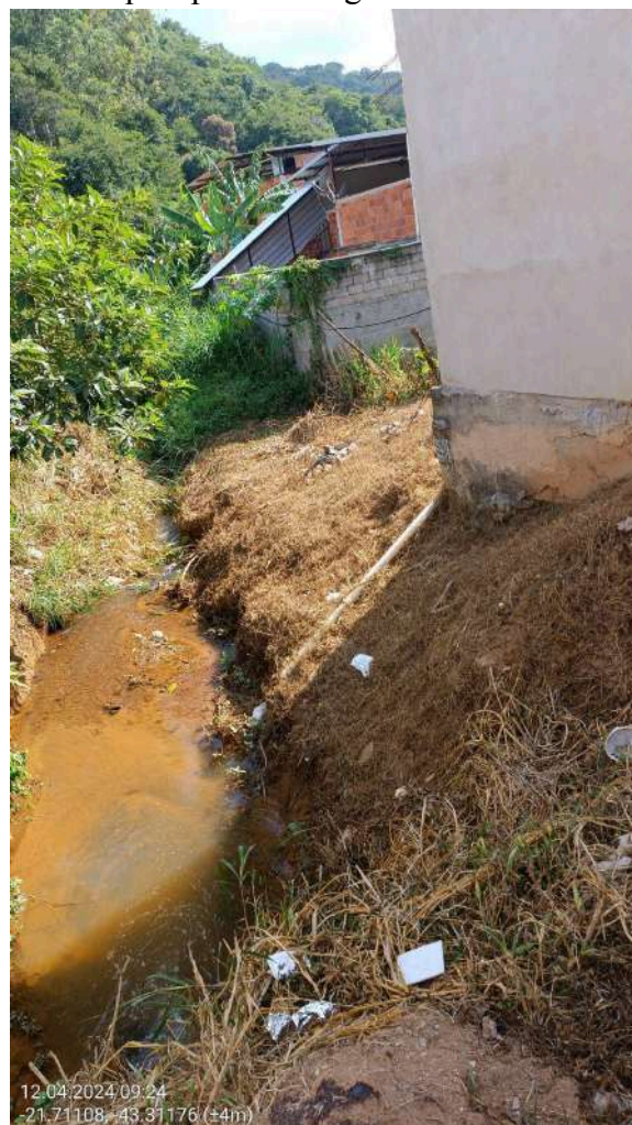
Figura 30 - Ponto 02 - Afluente do Ribeirão Yung - canal em condições naturais com trechos que apresentam grama alta.
