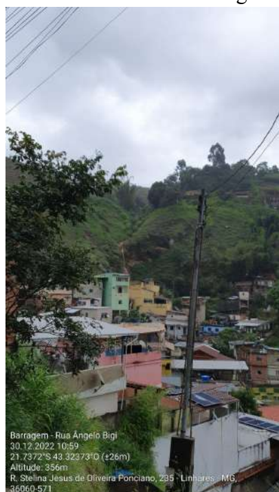
Figura 55 - Ponto 26 - Vista de encostas declivosas e da ocupação desordenada em parcela da bacia do Ribeirão Yung.
