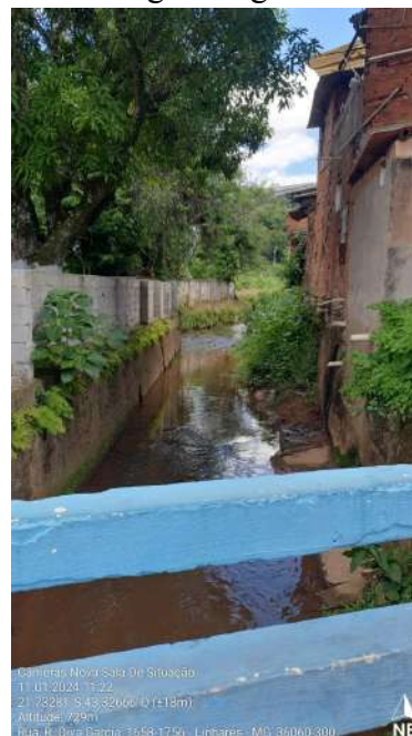
Figura 50 - Ponto 21 - Vista de seção do Ribeirão Yung na interseção entre as Ruas Diva Garcia e Ângelo Bigi.
