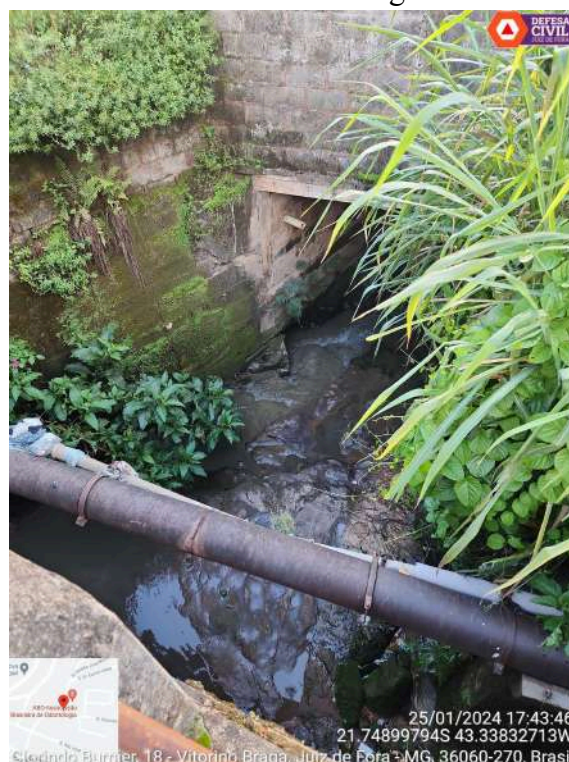
Figura 60 - Ponto 31 - Afluente do Ribeirão Yung em seção localizada à Rua Clorindo Burnier - Bairro: Vitorino Braga.
