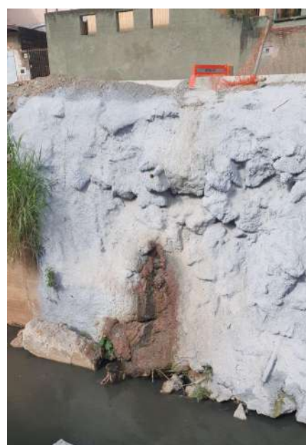
Figura 11 - Córrego Ipiranga - Juiz de Fora/MG - Avenida Santa Luzia - Bairro: Santa Luzia. Canal retilíneo com margens de pedra argamassada e fundo em cascalho.
