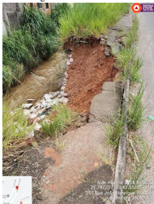
Figura 61 - Ponto 32 - Vista do Ribeirão Yung em seção localizada na interseção entre as Ruas João Henrique Vila Real e Vitorino Braga.
