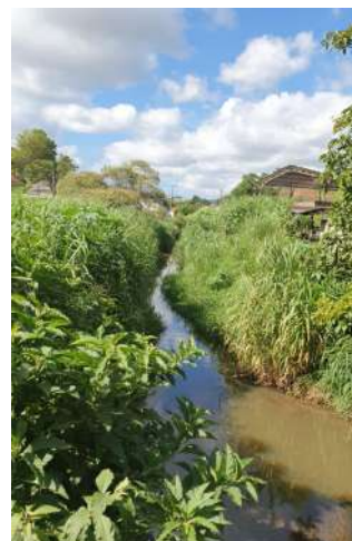
Figura 9 - Córrego Floresta - Juiz de Fora/MG - Rua João Pires de Almeida - Bairro: Jardim Esperança. Canal natural sinuoso, com grama alta.
