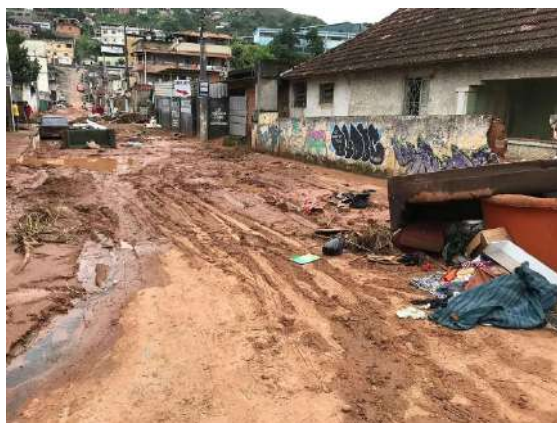
Figura 24 - Impactos da inundação ocorrida em dezembro de 2018 na Rua Itália - Bairro: Linhares.
