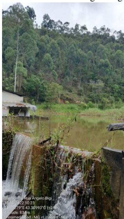
Figura 53 - Ponto 24 - Vista da condição de uso e ocupação do solo em seção da bacia localizada ao final da Rua Ângelo Bigi.
