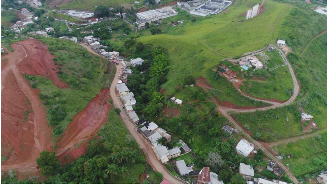
Figura 44 - Ponto 15 - Vista das condições de uso e ocupação do solo na bacia do Ribeirão Yung, na seção no entorno das Ruas Diva Garcia e Capitão Maurício Sávio.
