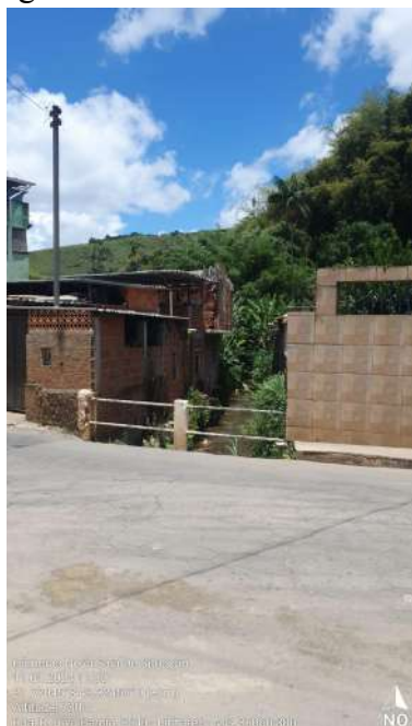
Figura 49 - Ponto 20 - Vista de seção do Ribeirão Yung com diversas edificações em suas margens.
