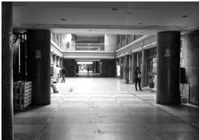
FIGURA 30. Galería Gallos-Mogollón (1959). Corredor
