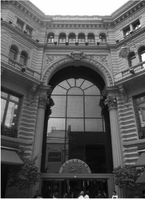
FIGURA 2. Galerías Pacífico: acceso Florida
