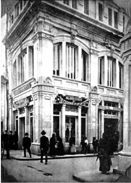
FIGURA 6. Fachada del edificio Hernández*
