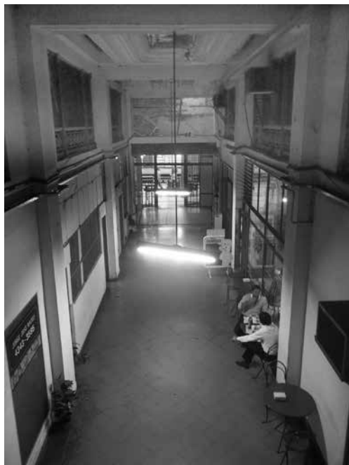
FIGURA 29. Galería subterránea del pasaje Roverano
