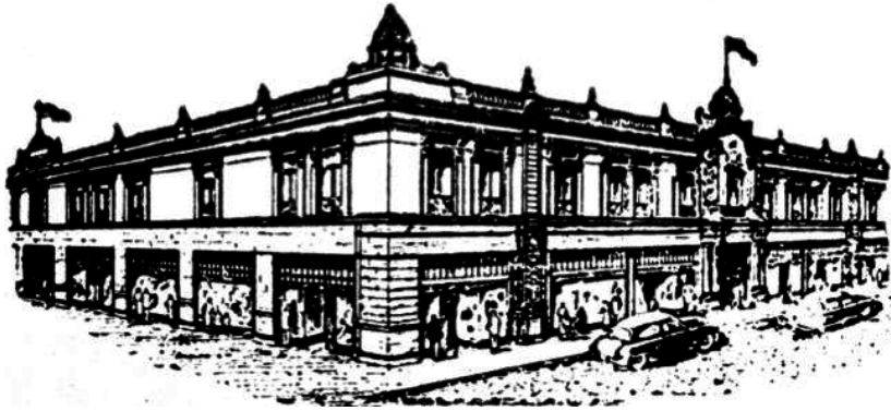
FIGURA 8. Edificio de la Alhóndiga
