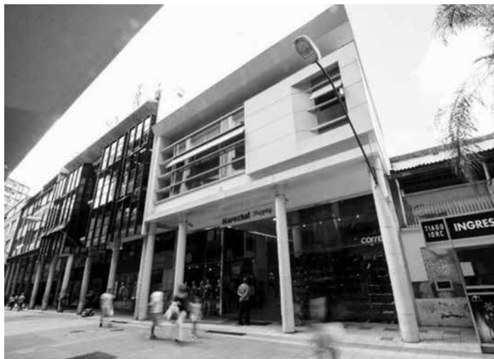
FIGURA 22. Marechal Shopping, fachada de la calle Mister Moore
