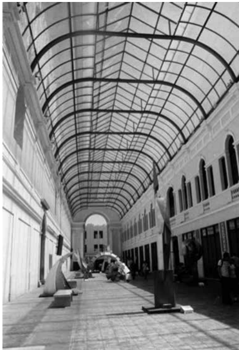
FIGURA 14. Interior del pasaje viendo hacia el arco de la 58
