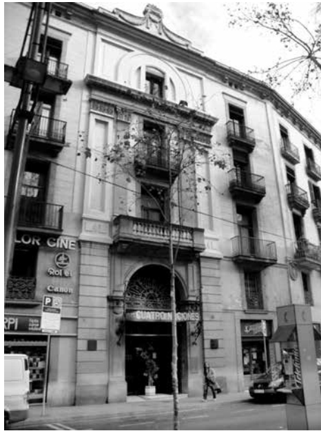
FIGURA 2. Fachada del hotel de Cuatro Naciones en la Rambla de Barcelona
