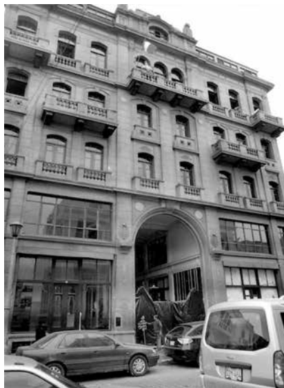
FIGURA 13. Pasaje Ronald (1929). Fachada principal
