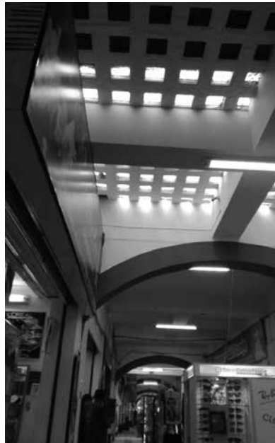
FIGURA 17. Vista del sistema de techumbre del pasaje De la Llata
