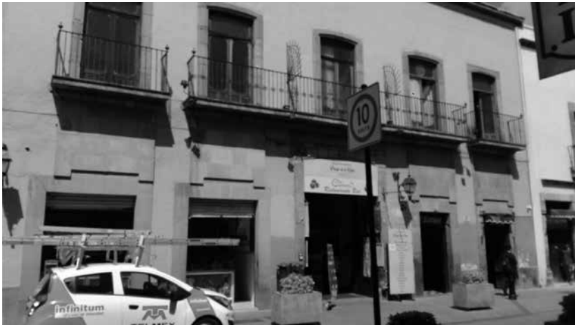
FIGURA 18. Pasaje comercial De la Llata. Fachada sur. Calle Francisco I. Madero
