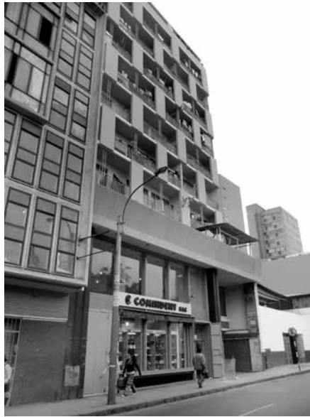
FIGURA 22. Galería Gallos-Mogollón (1959). Fachada-jirón Moquegua
