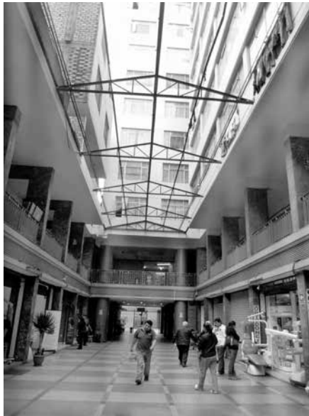
FIGURA 29. Galería Gallos-Mogollón (1959). Corredor
