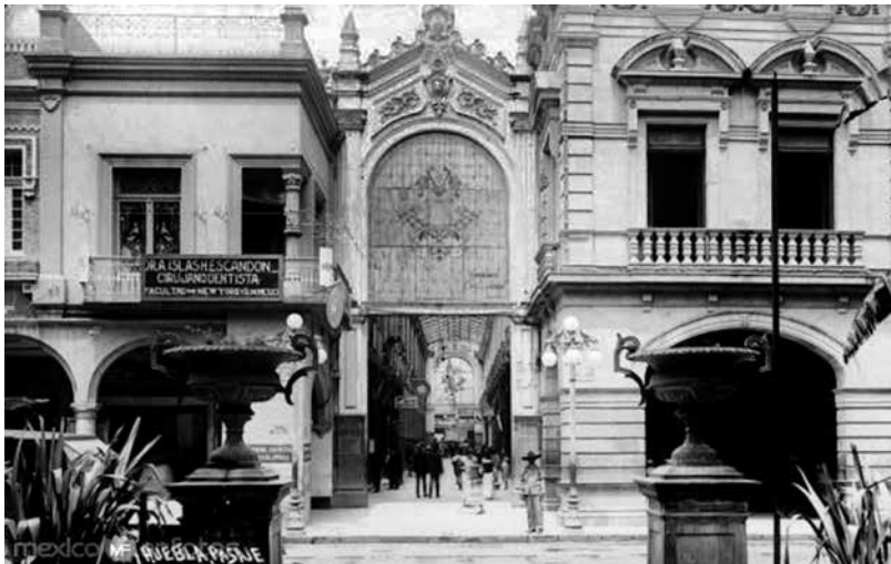
FIGURA 1. Vista antigua del pasaje del Ayuntamiento
