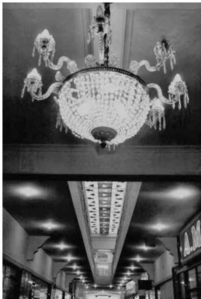
FIGURA 19. Vista del techo de la galería Pio X desde la planta baja
