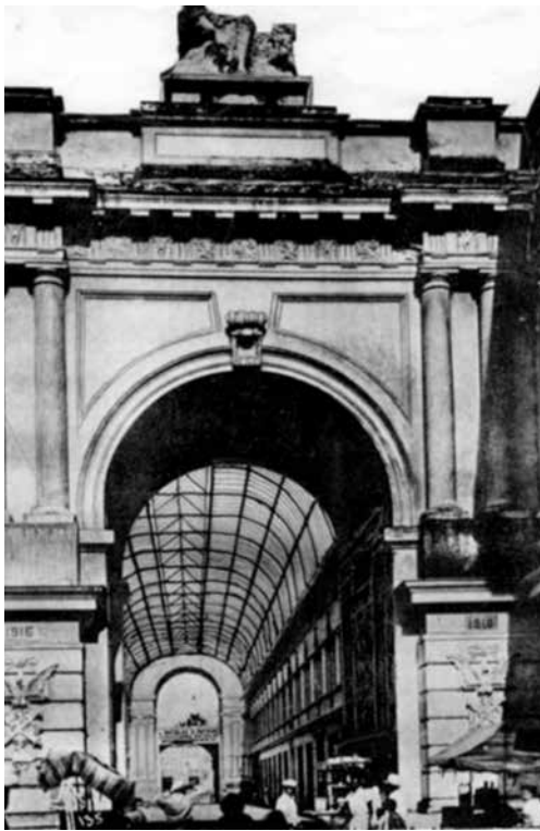
FIGURA 10. Fotografía del arco de la 60*
