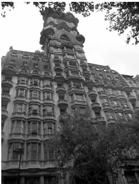
FIGURA 15. Fachada del Barolo: avenida de Mayo
