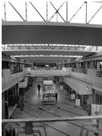
FIGURA 20. Galería Boza (1956). Corredor de los dos pisos
