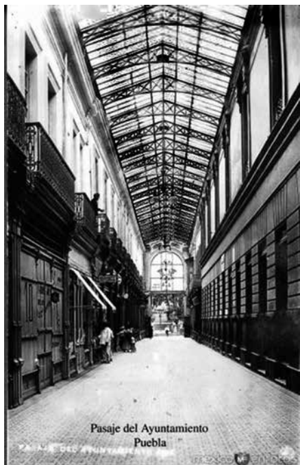
FIGURA 3. Vista antigua del pasaje del Ayuntamiento
