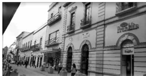
FIGURA 5. Calle de Francisco I. Madero. Casona De la Llata: cuarto edificio
