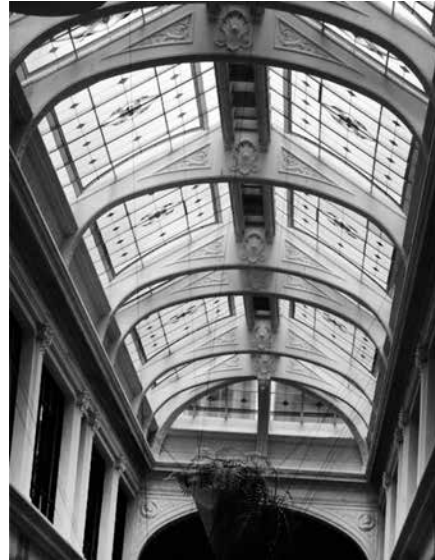
FIGURA 15. Pasaje Ronald (1929). Cubierta del corredor
