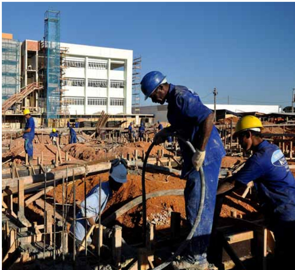
Obras e emprego na UFJF: pedreiros trabalham na construção de novo prédio para o ICH
