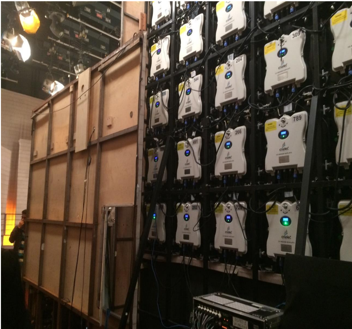
Figura 11: Bastidores: estrutura do fundo da plateia e estrutura para telão de led localizado ao fundo da banda (acervo pessoal – 18 de julho de 2016)
