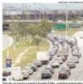
Tráfego congestionado na ponte Coronel João, em Florianópolis.
