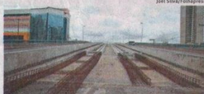
Viaduto do VLT de Cuiabá ainda está sem os trilhos
