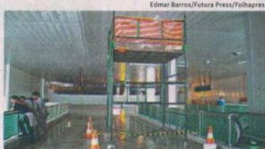
Andaime é instalado no aeroporto de Manaus (MA)
