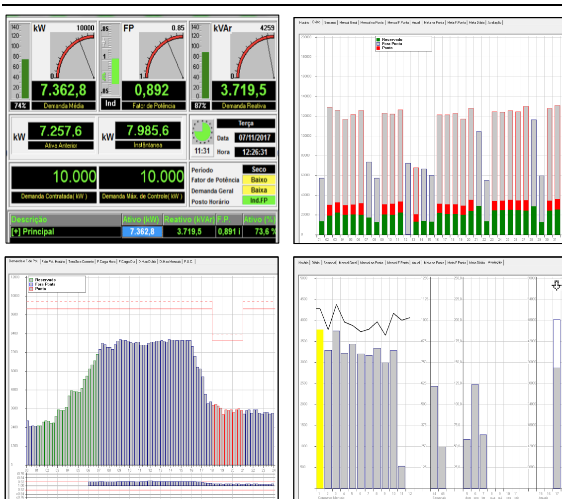
Figura 15. Imagens do Gerenciador CCK na Fábrica.
