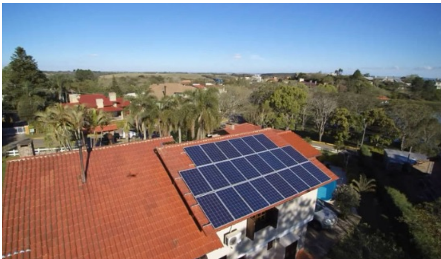
Figura 11 – Vista da instalação de painéis em uma residência localizada em Gravataí
