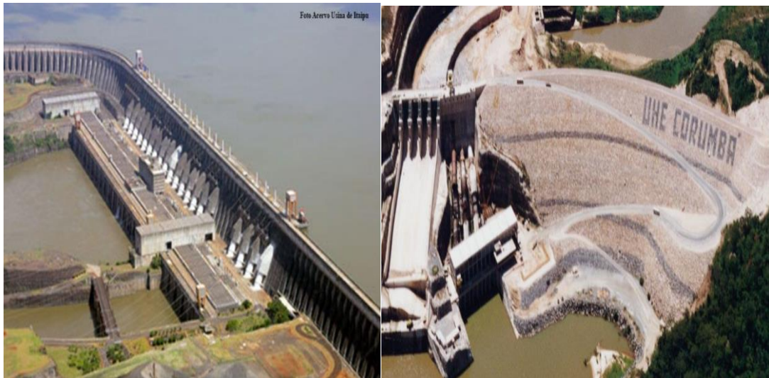
Figura 3 - Barragens de Concreto e de Enrocamento
