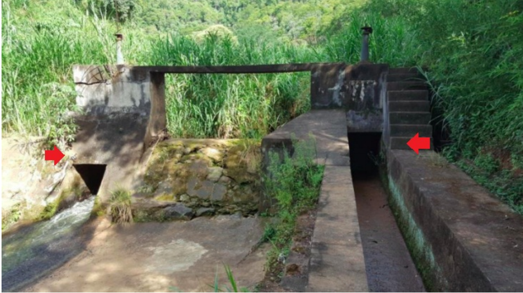
Figura 15 – Visão Frontal da Barragem.
