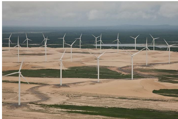
Figura 14 Parque Eólico de Praia Formosa - CE
