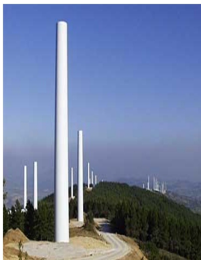
a) torre de concreto tubular 1
