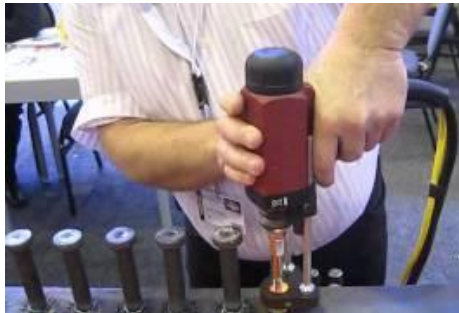
Figura 43 - Solda manual de pinos
