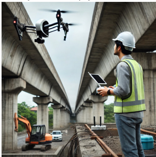
Figura 2 - Representação de uma inspeção visual com utilização de drone
