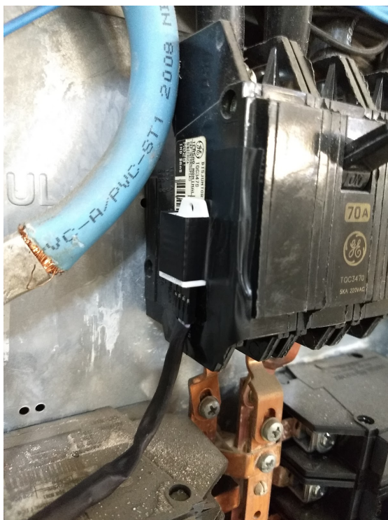
Figura 11: Termohigrômetro posicionado no disjuntor principal
