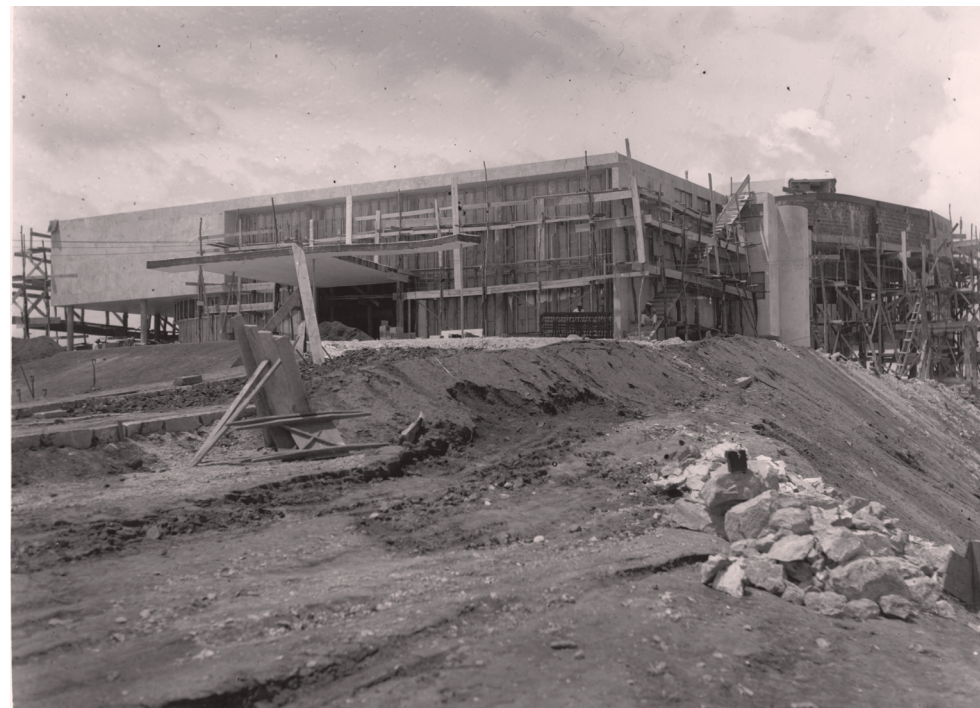
Prédio do Cassino da Pampulha em construção. Agosto de 1943, autor não identificado. Acervo Museu Histórico Abílio Barreto, Belo Horizonte, MG.
