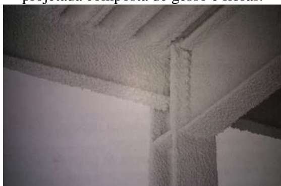
Figura 38 – revestimento em argamassa projetada composta de gesso e fibras.
