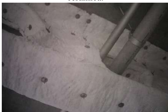
Figura 40 – revestimento de manta cerâmica.
