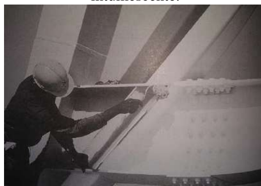
Figura 39 – revestimento com pintura intumescente.
