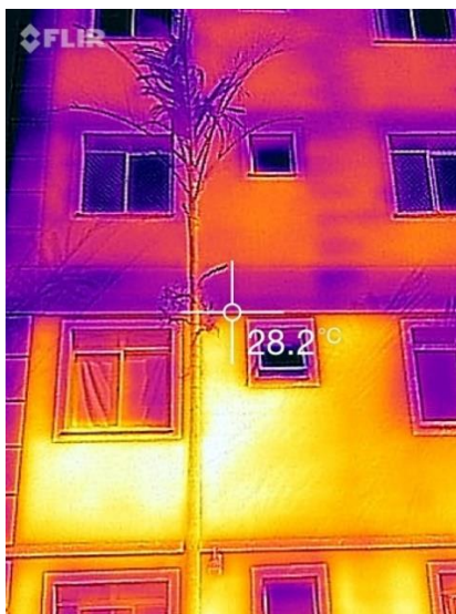
Bloco G, fachada lateral direita
