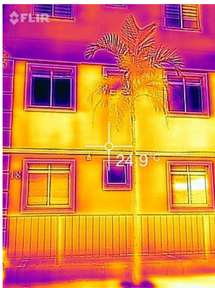
Bloco G, fachada lateral esquerda
