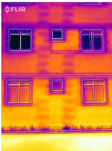
Bloco C, fachada lateral esquerda
