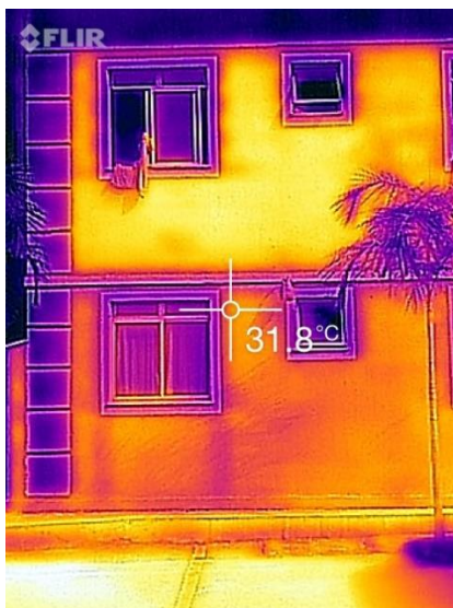
Bloco C, fachada lateral direita
