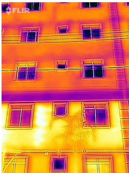
Bloco P, fachada lateral esquerda
