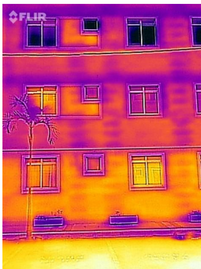
Bloco C, fachada lateral direita
