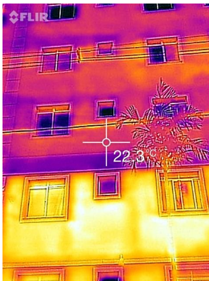
Bloco J, fachada lateral esquerda
