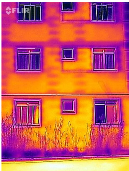
Bloco A, fachada lateral esquerda
