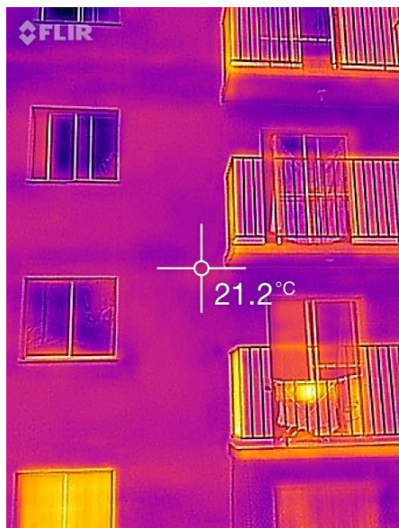
Bloco E, fachada posterior
