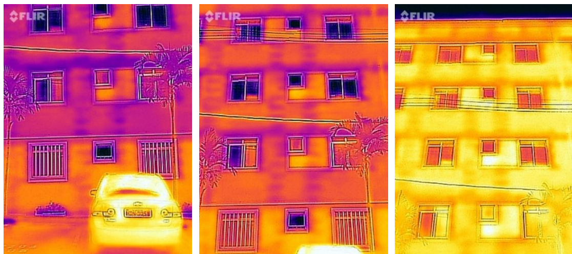
a) Termograma a 0^\circ
