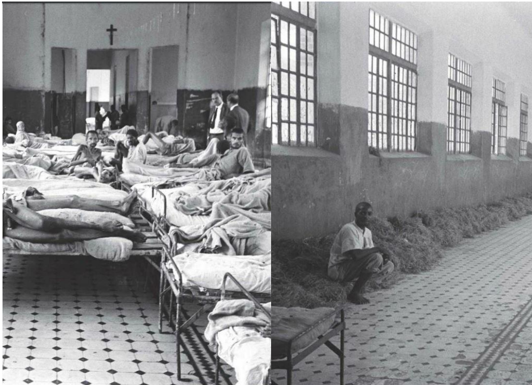
Figura 14 e 15: Leitos do Hospital Colônia antes da superlotação
