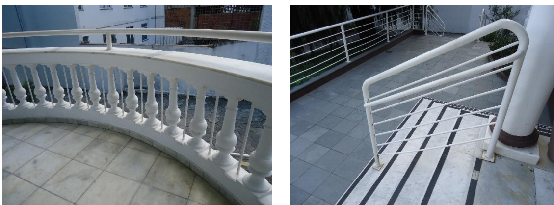
Figura 54: Detalhe do reforço na segurança dos balaústres (à esquerda), e guarda-corpo instalado posteriormente na escada de acesso principal (à direita)
