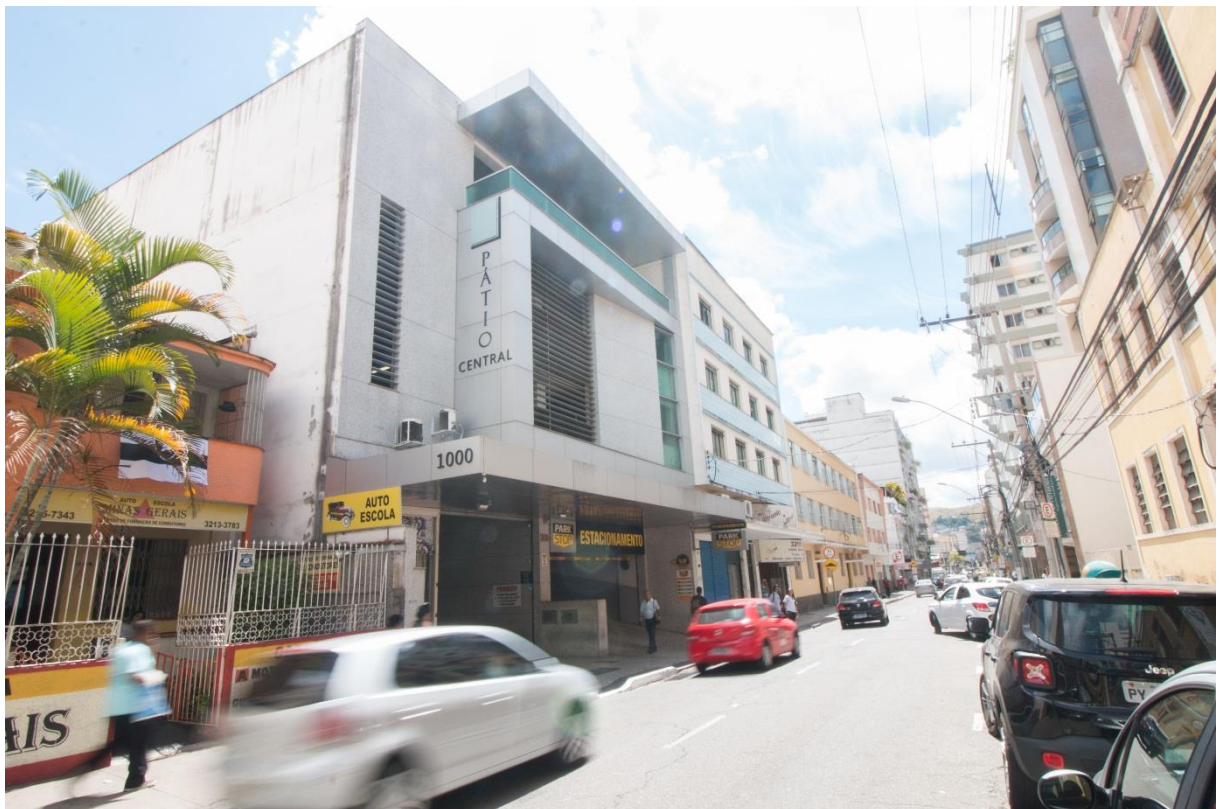
Figura 23: Pátio Central, fachada da Rua Espírito Santo
