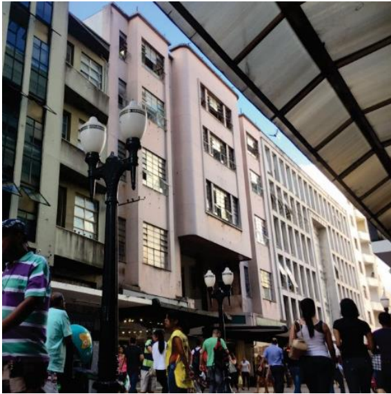
Figura 10: Fachada da galeria Pio X, Rua Halfeld, 2016 O Autor
