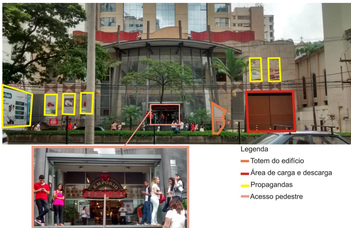
Figura 64 – Detalhe da fachada do edifício Milênio Center
