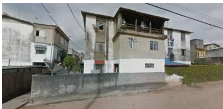
Figura 1 - Modificações e descaracterização de um conjunto habitacional do período do BNH no município de Juiz de Fora - MG, por meio da construção de um anexo representativo da inadequação dos projetos à realidade das famílias
