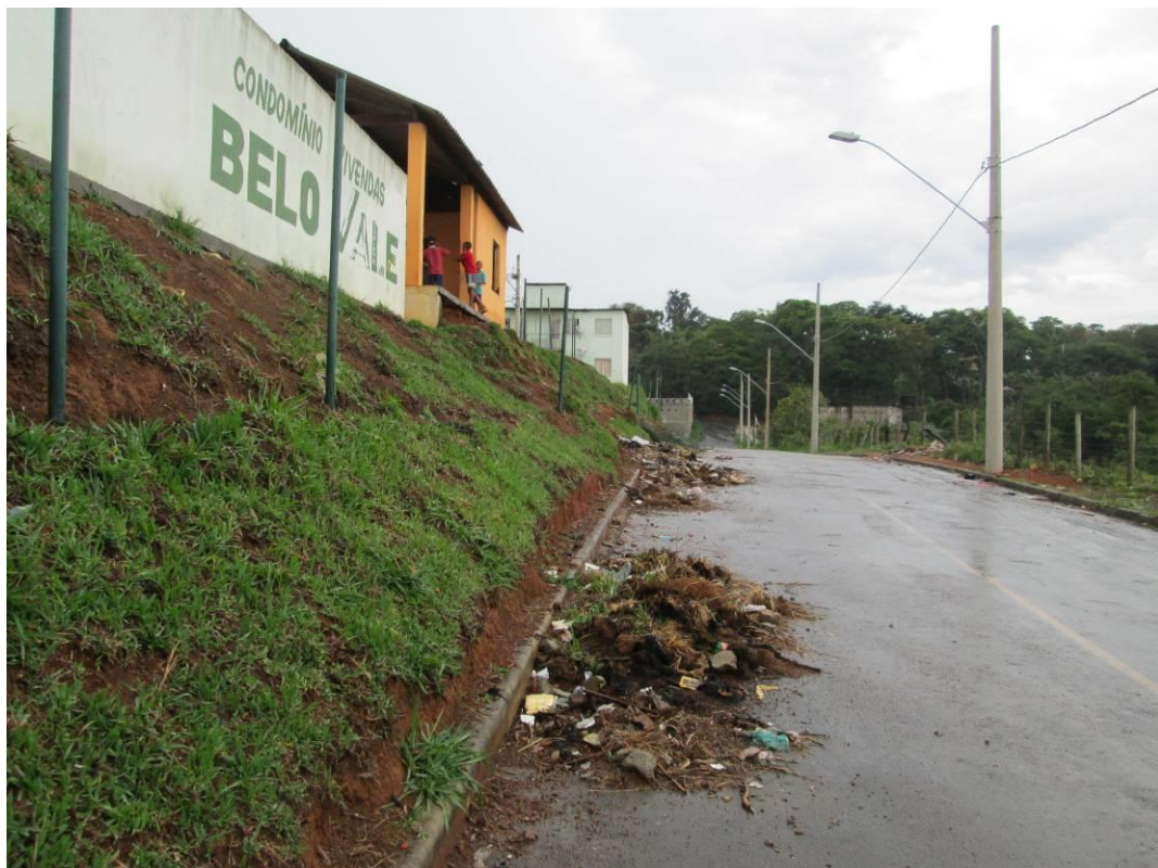
Figura 2: Fachada do condomínio
