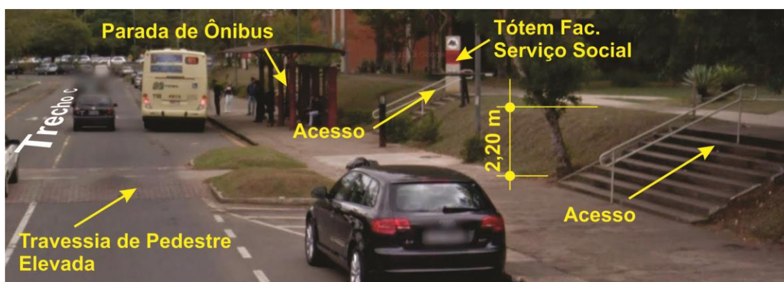
Figura 29 – Detalhes do trecho C.
