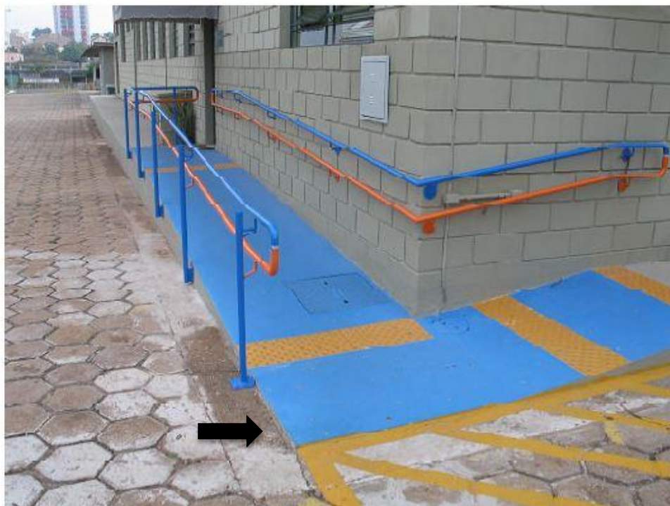
Figura 13 – Rampas de acesso com guia rebaixada, com sinalização tátil e em conformidade com a NBR 9050.
