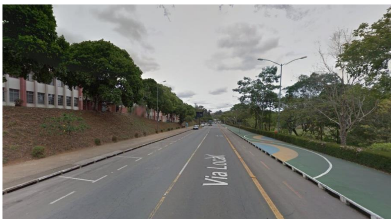
Figura 39 – Vista do Trecho A
