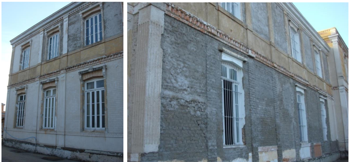
Figura 84 e figura 85: Fachada lateral esquerda não concluída.
