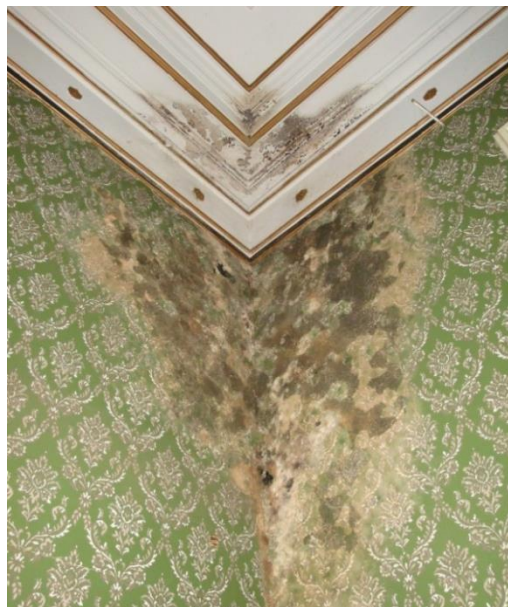
Figura 76: Infiltração nas paredes internas da Villa, comprometendo o papel de parede.
