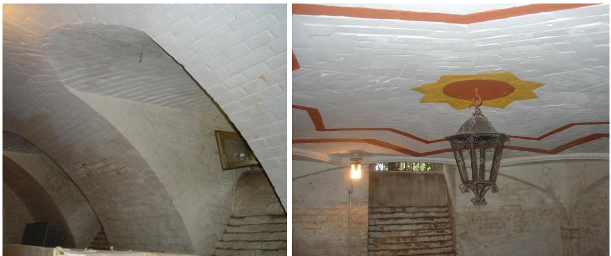
Figura 45 e figura 46: Laje de tijolos maciços no subsolo.
