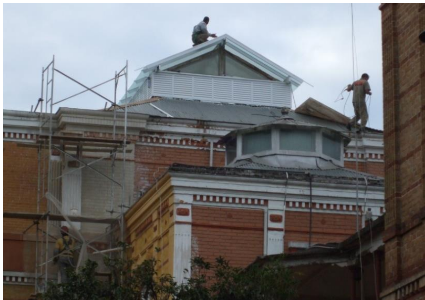
Figura 102: Instalação dos vidros a cobertura do lanternim.
