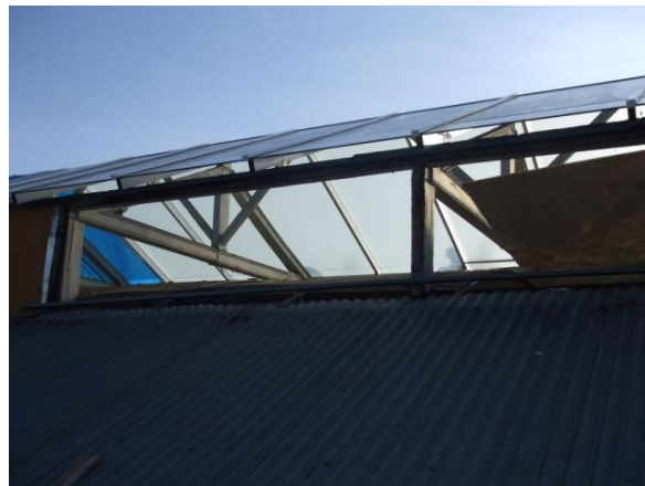
Figura 100 e figura 101: Retirada das venezianas metálicas que constituem a lateral do lanternim.
