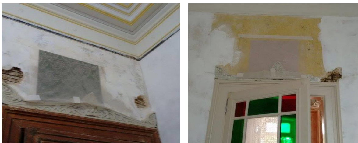
Figura 108 e figura 109: Retirada do papel de parede instalado na década de 1970.
