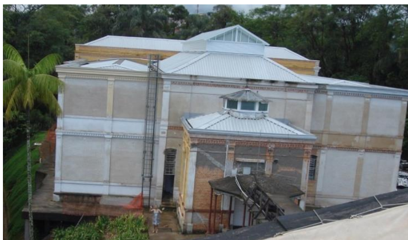
Figura 103: Lanternim e Claraboia do Prédio Mariano Procópio.
