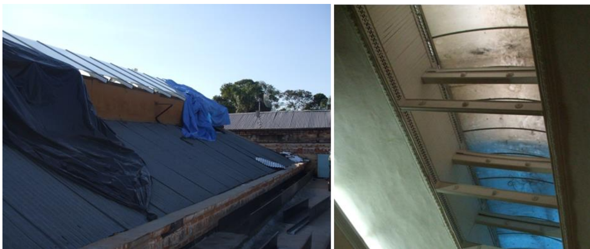
Figura 98 e figura 99: Substituição das telhas do lanternim e sobrecobertura usada durante a execução.
