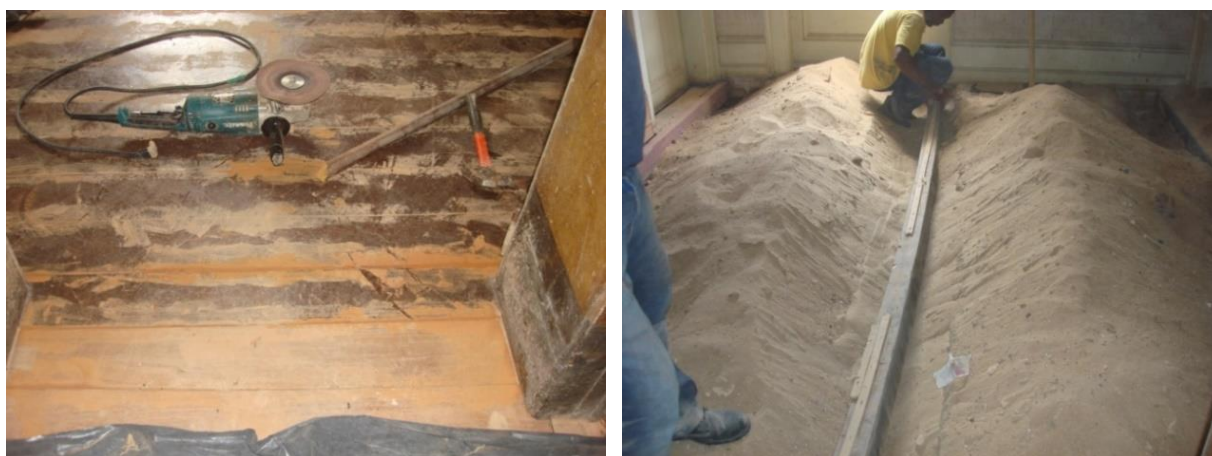
Figura 106 e figura 107: Restauração do piso de madeira.
