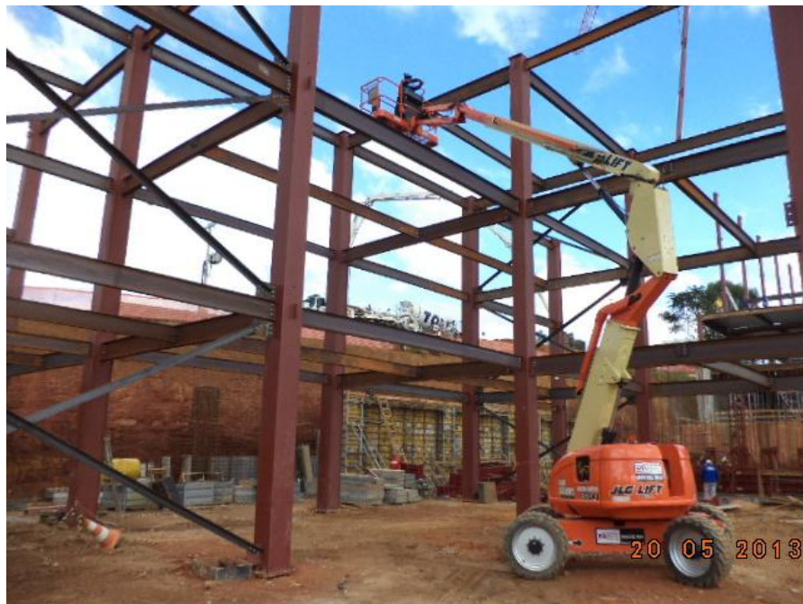
Figura 18 – Montagem de estrutura metálica. Fonte: AUTOR (2013).
