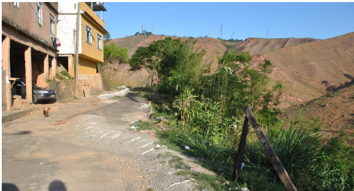
Figura 38 – Via estreita com infiltração por inexistência de captação pluvial
