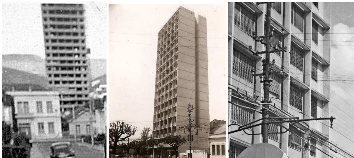
Figura 85 – Detalhe da fachada do edifício Excelsior.
