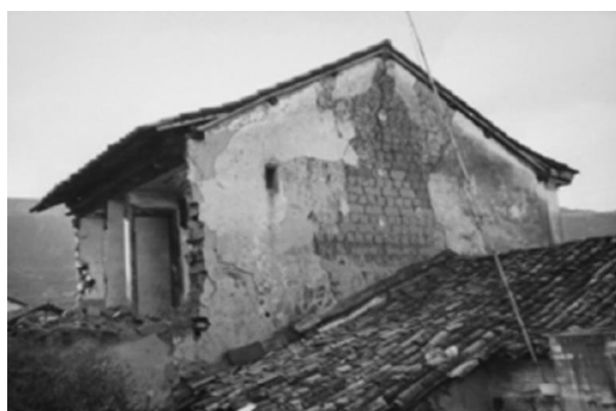
Figura 10: Imóvel Localizado na Rua Direita
