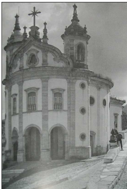
Figura 2.7 – Igreja de Nossa Senhora do Rosário dos Homens Pretos em Ouro Preto, construída em alvenaria de pedras com planta curvilínea (OLIVEIRA, 2008).
