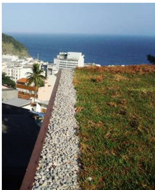
Figura 15- Sistema de drenagem pronto com brita construído lateralmente. Fonte:< www.tibarose.com/port/projetos-babilonia.php >. Acesso em: 23/04/2012.
