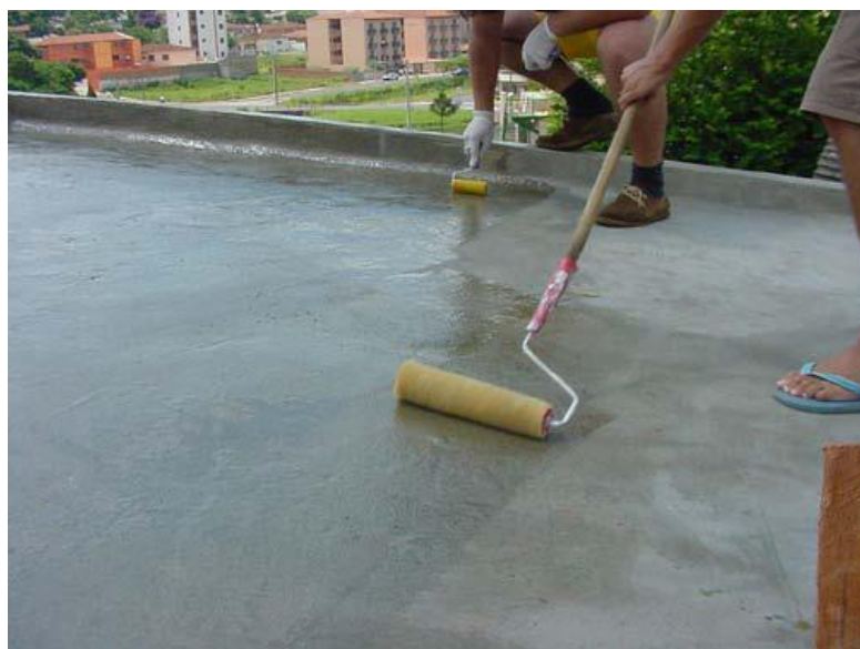
Figura 22 - Aplicação do impermeabilizante com rolos de pintura Fonte: Lima (2004).
