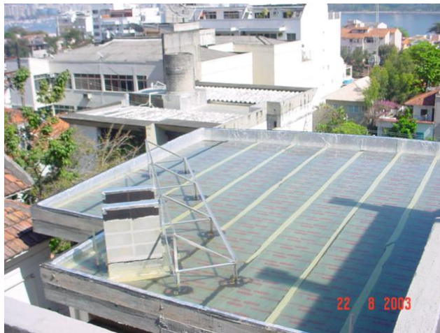
Figura 41 - Teste de estanqueidade para melhor garantia do sistema. Fonte: Lichtenberg (2006).
