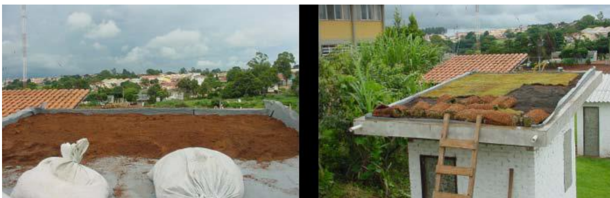
Figura 24 - Colocação de substrato sobre o geocomposto e colocação da grama Fonte: Lima (2004).
