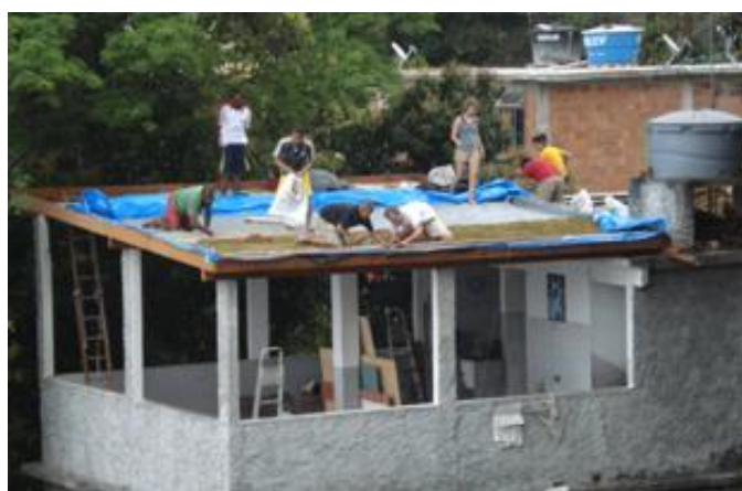
Figura 13- Execução das várias camadas simultaneamente.
