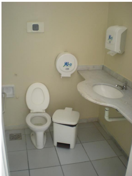
Figura 29 – Banheiro da enfermaria (Fonte: a autora).
